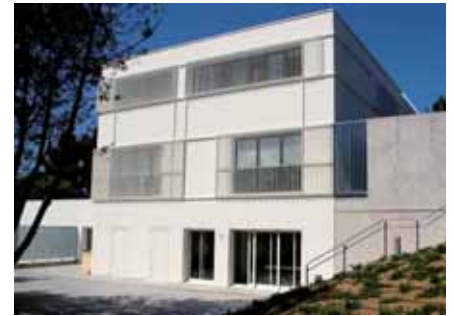
Noves Instal·lacions de Bellaire
